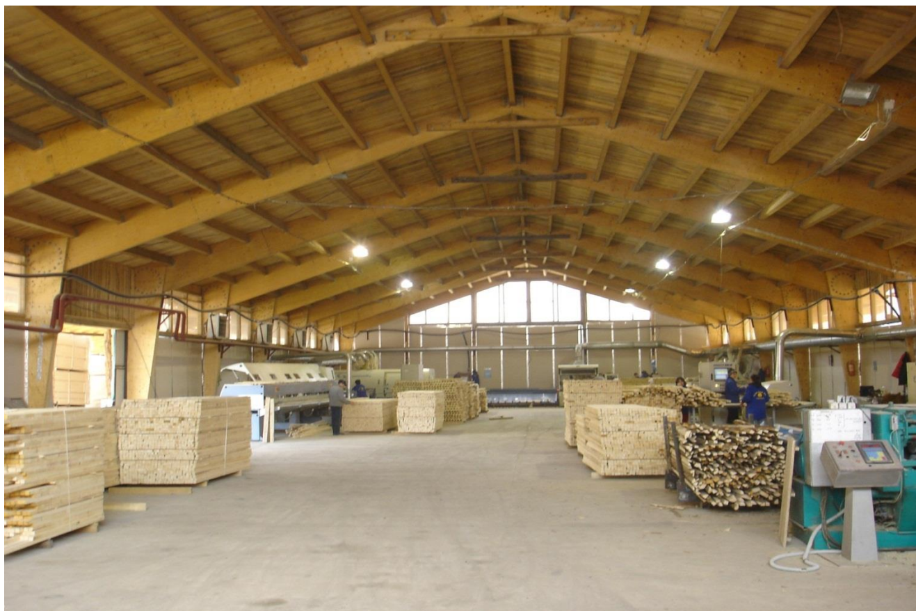
Hala semifabricate 2 (vedere interioară)
